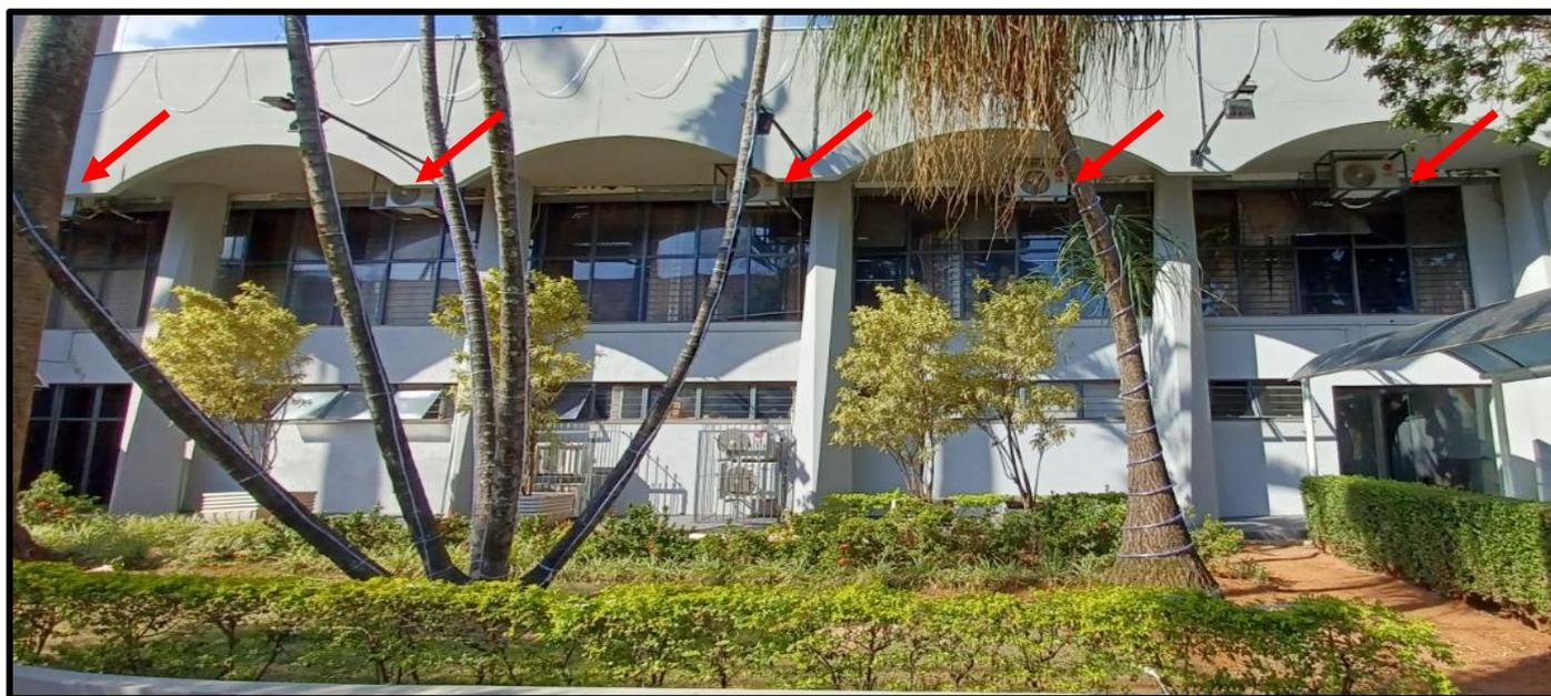
*Figura 1: Foto da fachada da Câmara Municipal de Indaiatuba apontando as condensadoras que deverão ser reposicionadas*
