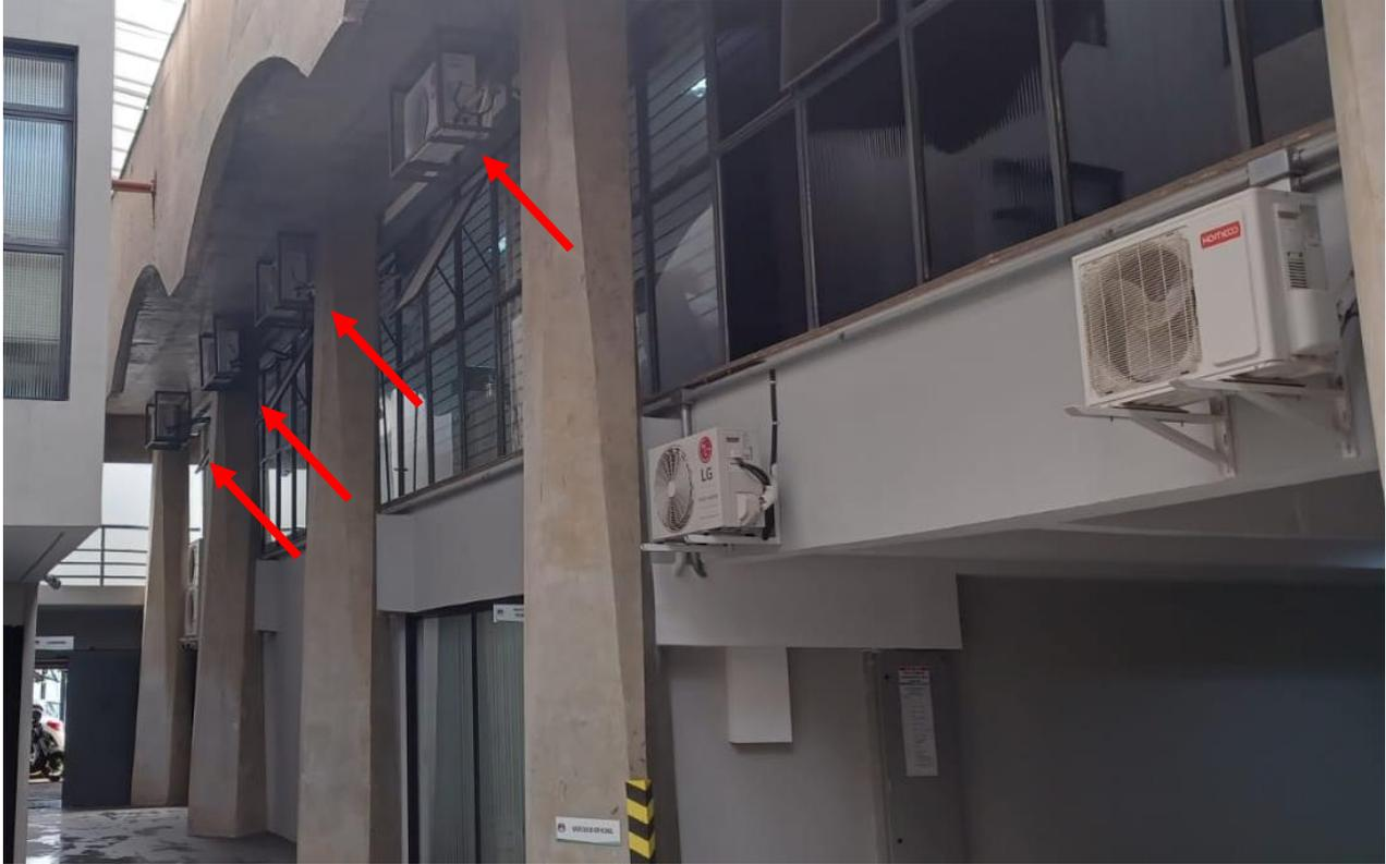
*Figura 4: Foto do corredor entre o prédio administrativo e o prédio dos gabinetes dos vereadores indicando as condensadoras que deverão ser reposicionadas.*
