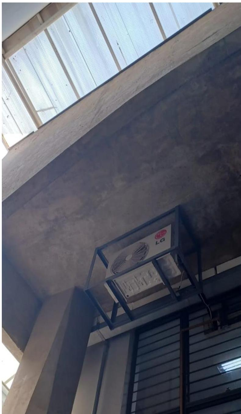
*Figura 3: Detalhe da estrutura formada pela gaiola de aço e da condensadora de ar condicionado.*
